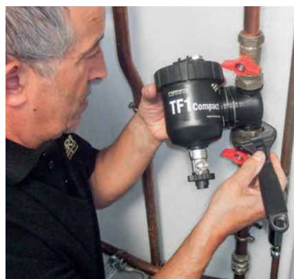
Instalacja filtra FERNOX TF1 Compact
