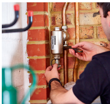
Instalacja filtra FERNOX TF1 Omega
