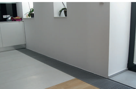
Ogrzewanie podłogowe kanałowe – REGULUS®-system CANAL
