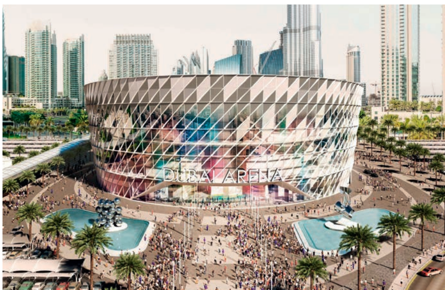
Dubai-Arena, Dubaj, Zjednoczone Emiraty Arabskie. Wykorzystano tu 46 kurtyn powietrznych WING.
